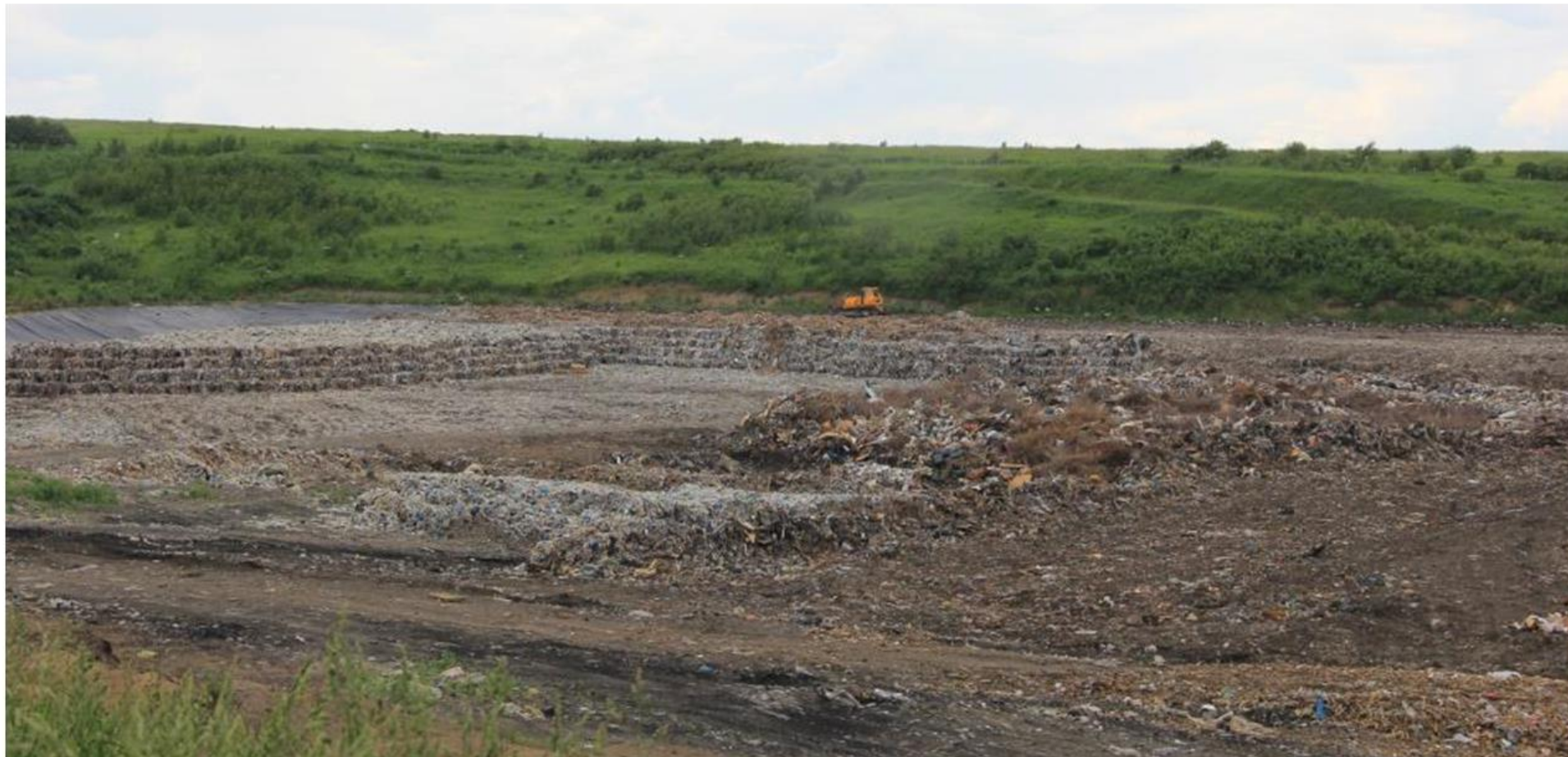
Захоронение отходов на полигоне
