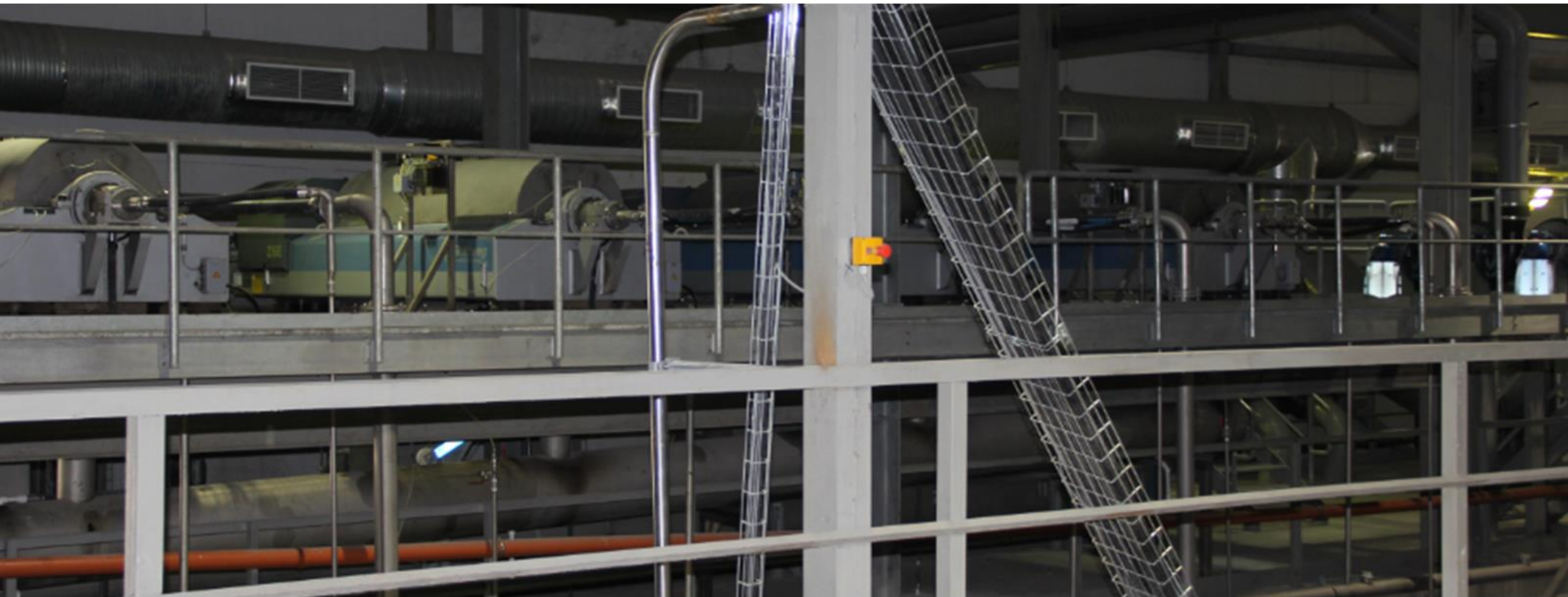
Цех очистки воды
